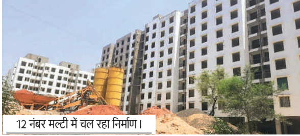
12 नंबर मट्टी में चल रहा निर्माण।
